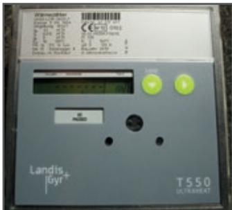
Wärmemengenzähler zur Abrechnung Heizung und/oder Warmwasser.
